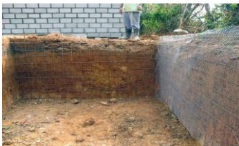
Figura 2 – Impermeabilizar escavação com ferro
