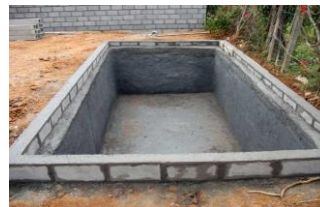
Figura 3 – Impermeabilizar escavação com cimento
