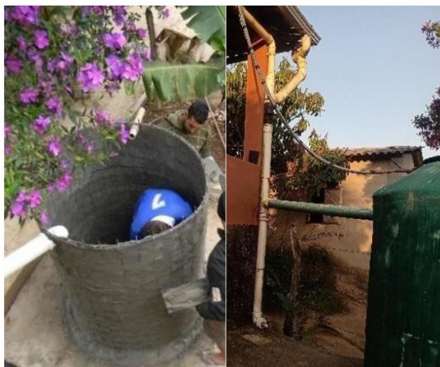
Figura18 – Instalação hidráulica: conexão do tubo vindo da calha ao tanque
