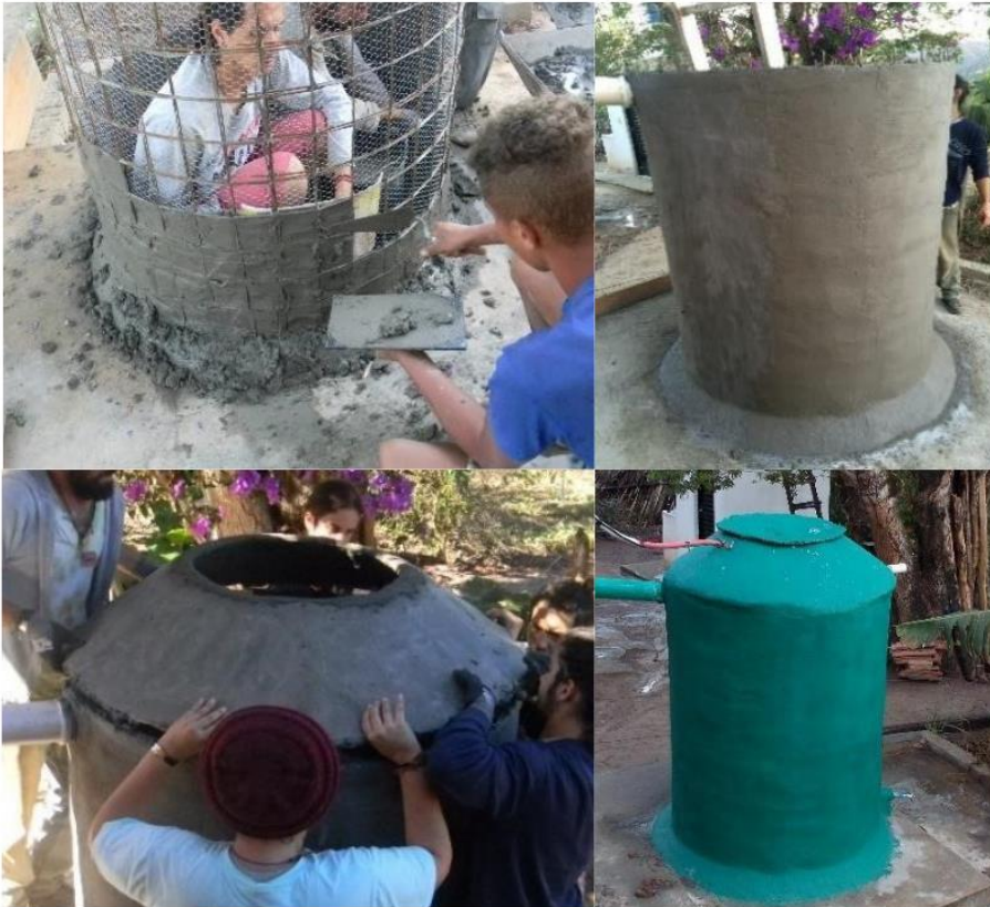
Figura 19 – Cobertura do tanque e da tampa com cimento e finalização com a pintura
