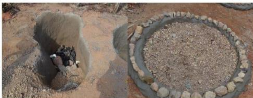
Figura 6 – Construção do segundo tanque
