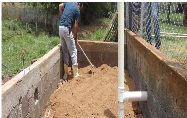
Figura 6 – Camadas de materiais (brita/areia/terra)
