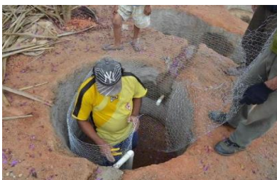
Figura 5b —Chapiscamento dos buracos, fixação de telas e estação dos canos
