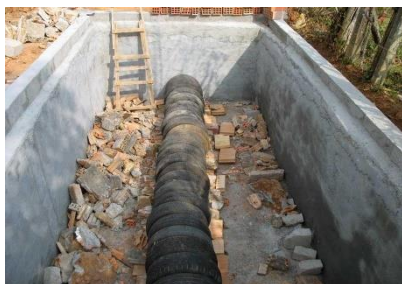
Figura 4 – Construção da câmara de pneus e adicionando os entulhos de obras
