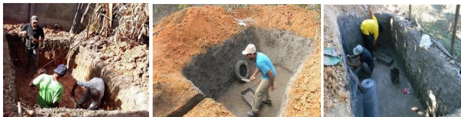
Figura 2 – Passos 1 e 2 da construção da BET.
