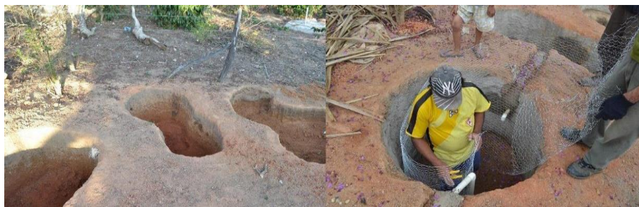
Figura 7 – Passos iniciais para construção do Filtro Biológico
