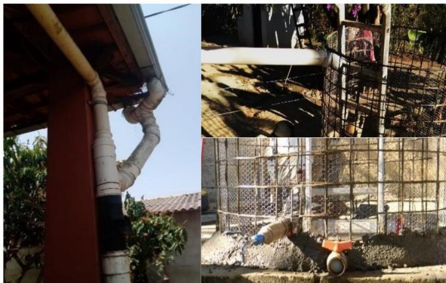
Figura17 – Instalação das conexões hidráulicas: tubos conectados na calha (à esquerda) e no tanque (direita acima); registros conectados no tanque (direita abaixo)
