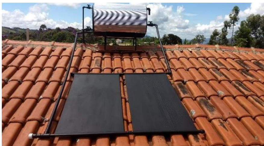
Figura 14 – ASBC pronto e instalado no telhado
