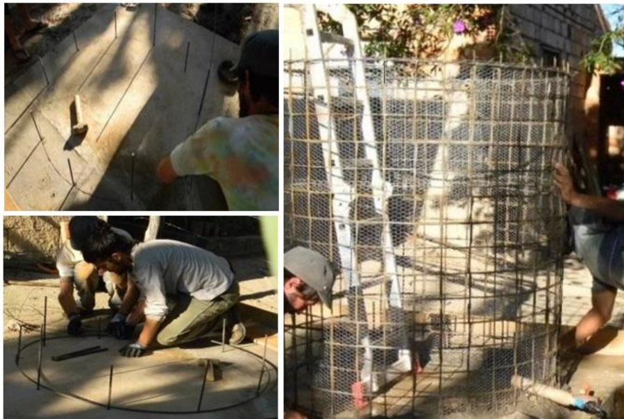
Figura 16 – Marcação da circunferência do tanque, confecção da malha pop e fixação da tela galvanizada
