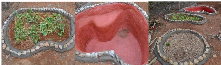
Figura 9 – Finalização da construção do Filtro Biológico
