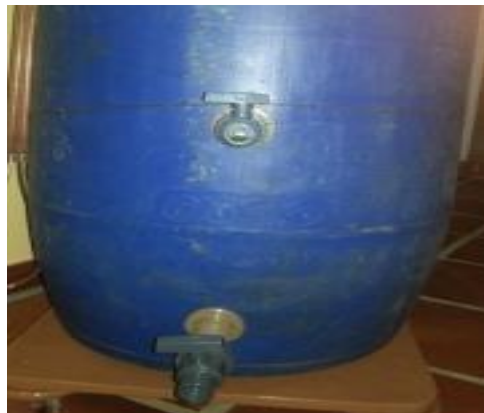
Figura 22 – Local dos 2 furos na lateral superior e inferior da Bombona
