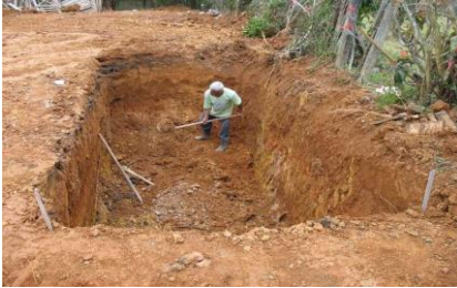
Figura 1 — Escavação do solo.
