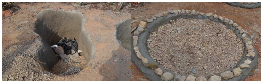
Figura 8 – Passos intermediários de construção do Filtro Biológico
