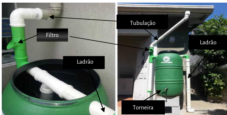
Figura 4: Exemplo de Sistema de captação de água
