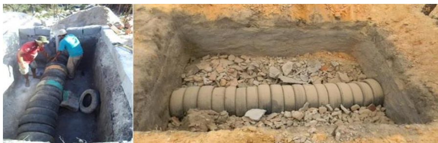
Figura 3 – Passos 3, 4 e 5 da construção da BET
