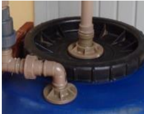
Figura 21 – Local dos 2 furos no meio e na lateral da tampa
