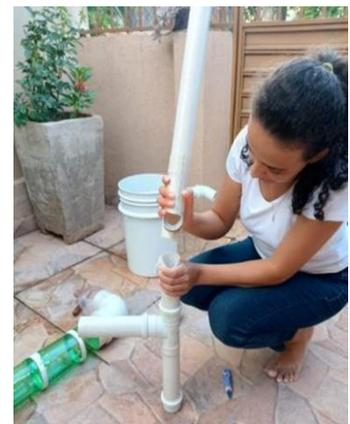
**Passo 3:** Montagem do tubo de queda de água, filtro, Tê para divisão da 1ª água de chuva e o reservatório - tubo de saída de água pelo ladrão - torneira para saída de água
